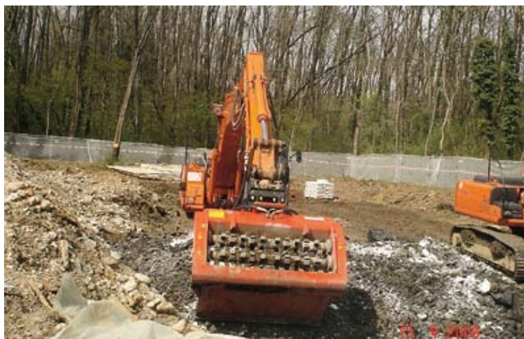
3 - Pala miscelatrice in azione in una discarica di melme acide, stabilizzate mediante l'aggiunta di idrossido di calcio
